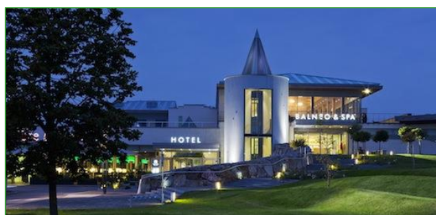
Hôtel chauffé par la biométhanisation en Alsace. (© Bioénergie international)
