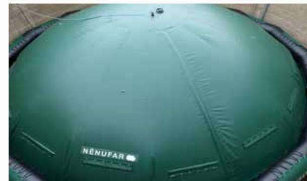
Unité de biométhanisation par cuve à lisier couverte. La membrane recueillant le biogaz flotte sur le lisier. Aucune modification de la fosse n'est réalisée, ni pour l'alimentation ni pour le pompage.
