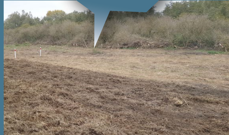
Préparation du sol
